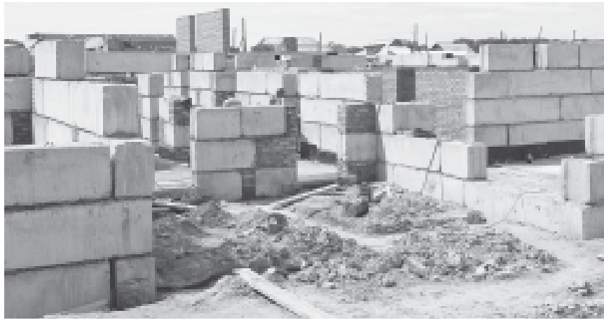
Строительная площадка будущего детского сада в мкр. Молодёжный в Балахте
